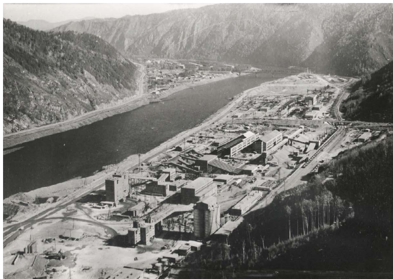
Большой бетонный завод, на дальнем плане на левом берегу п. Черёмушки
