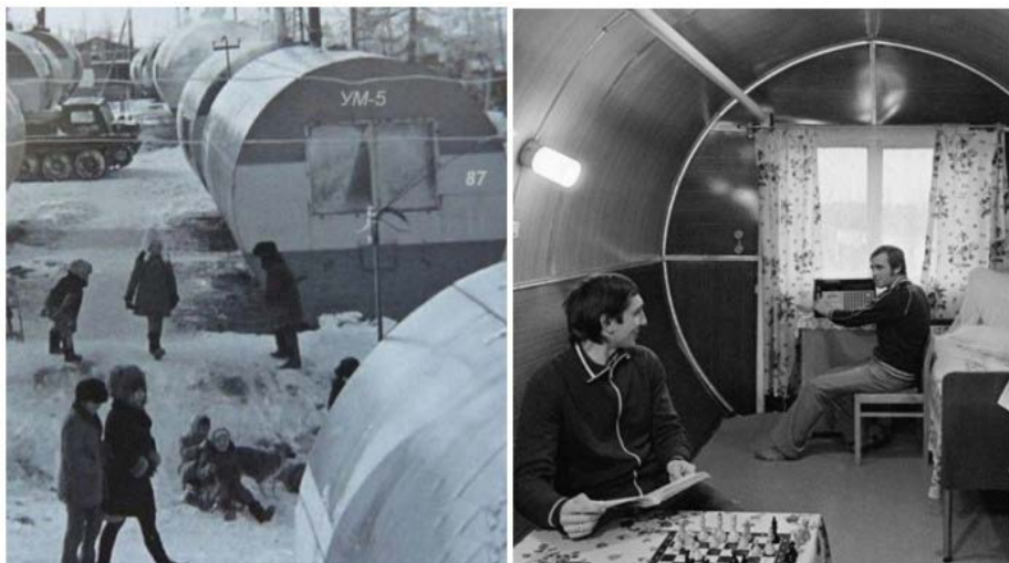
ЦУБ – цилиндрические унифицированные блоки, предназначались для проживания людей. Дом из цистерны – конструкция из области «необъяснимо, но факт».
